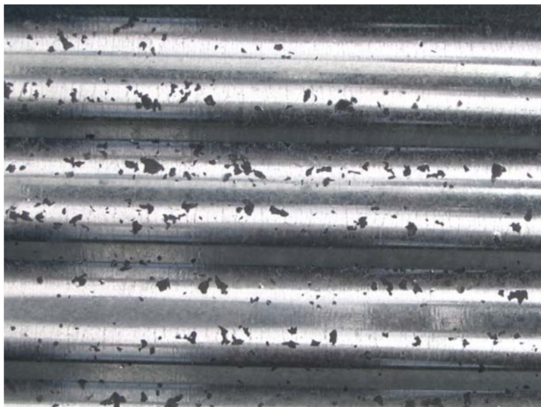
Figura 2 – Manchas resultantes de corrosão por atrito em chapas galvanizadas.
